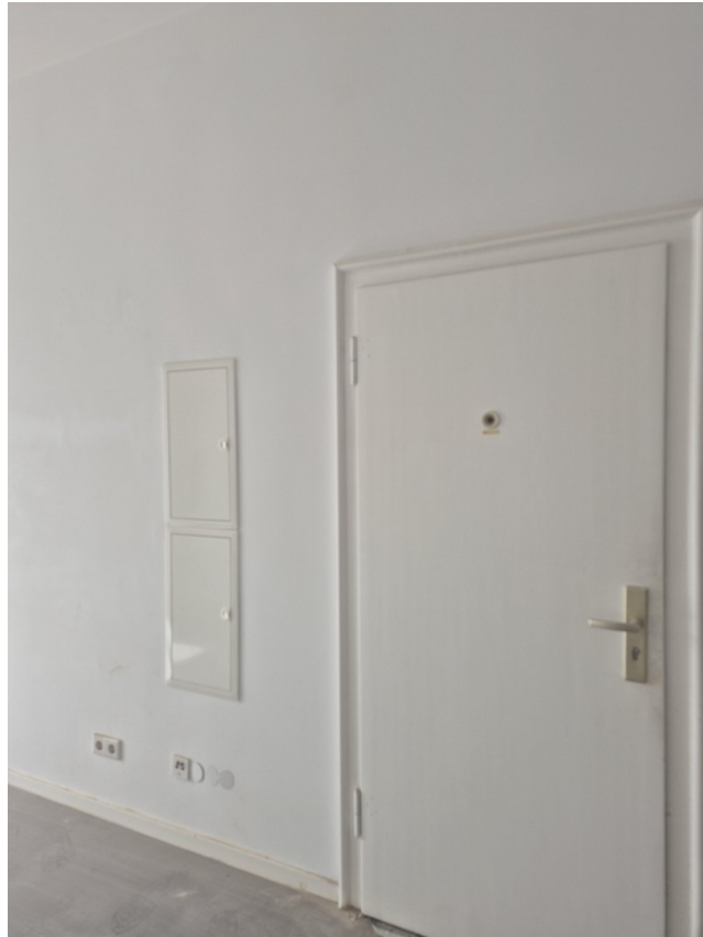
Etage 5 Eingang links
