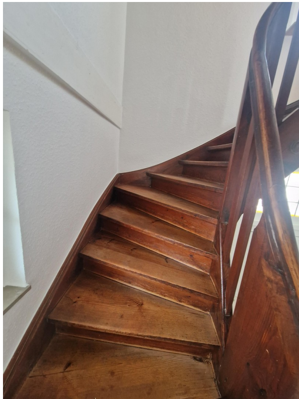
Treppe ins 1 OG
