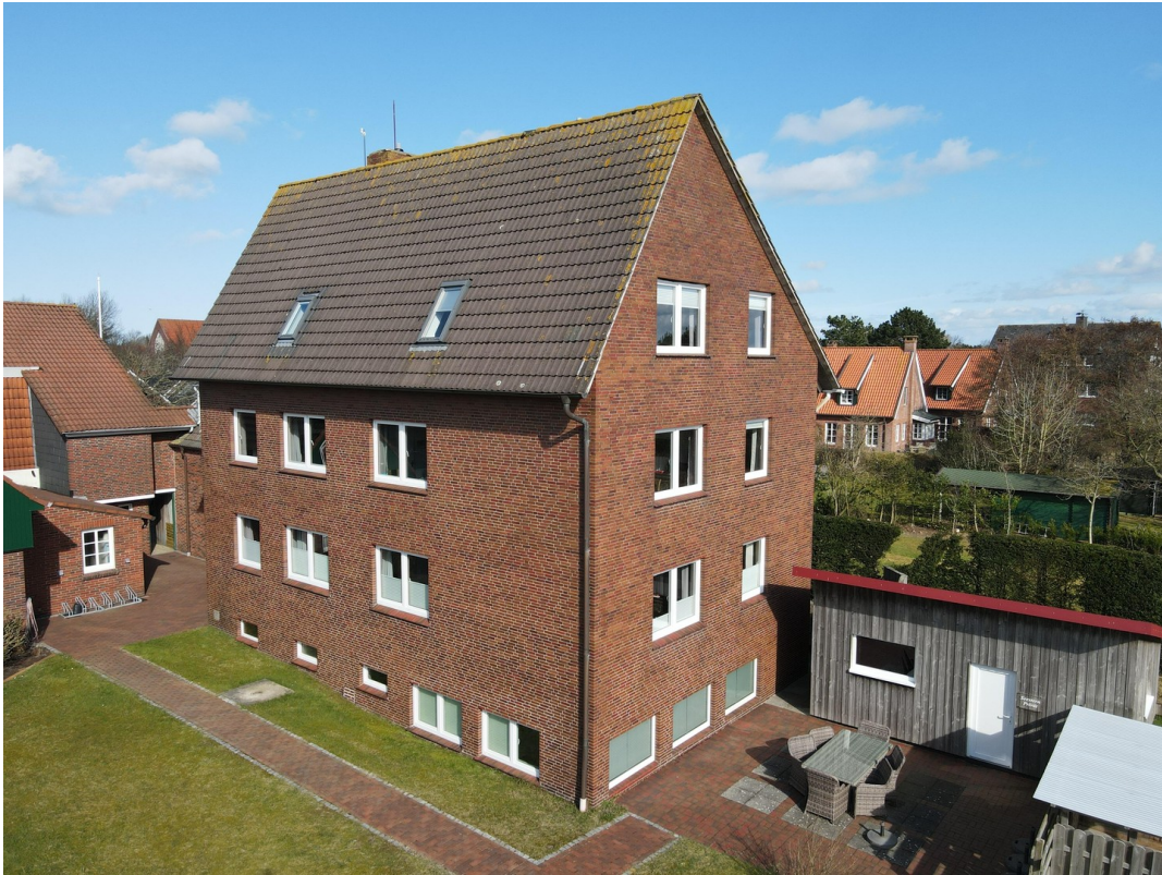
Ansicht von Außen
