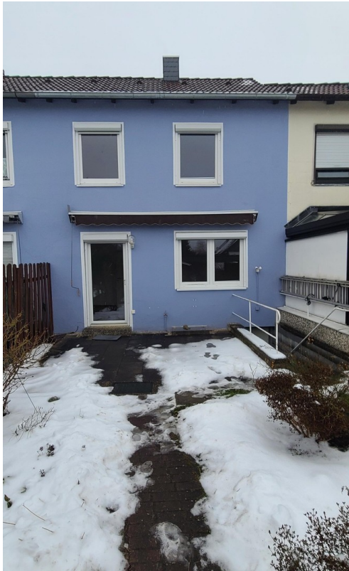
Hinterseite mit Terrasse
