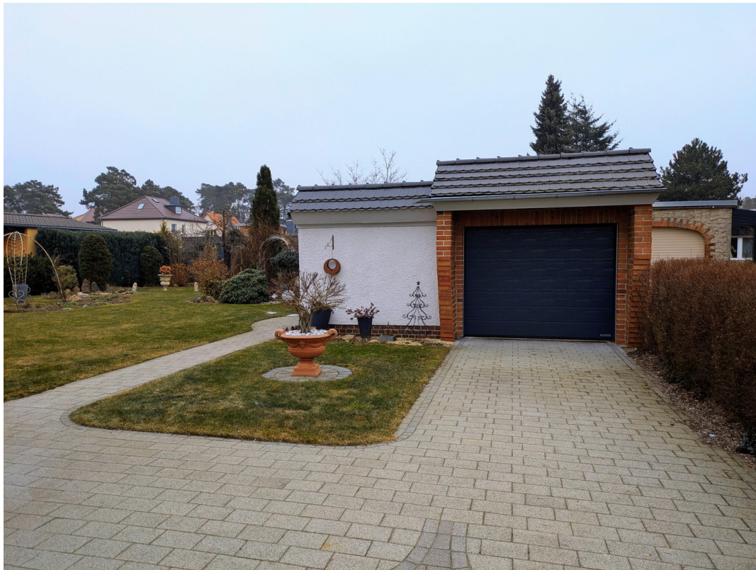
Einfahrt und Garage
