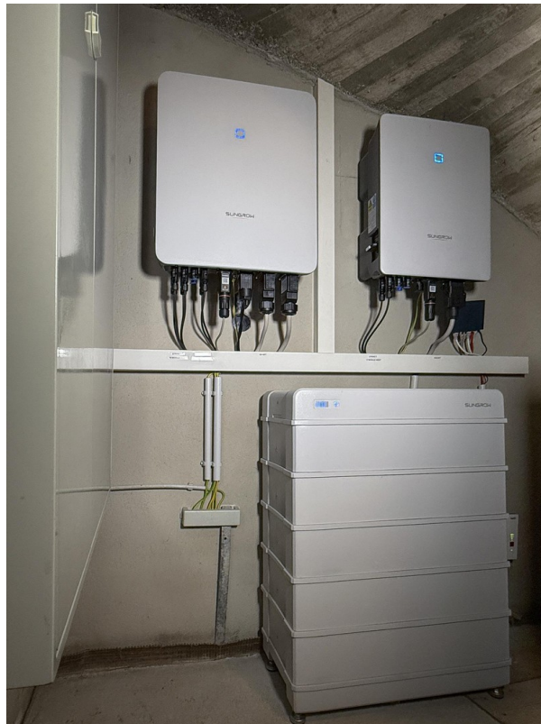
PV: Wechselrichter und Speicher
