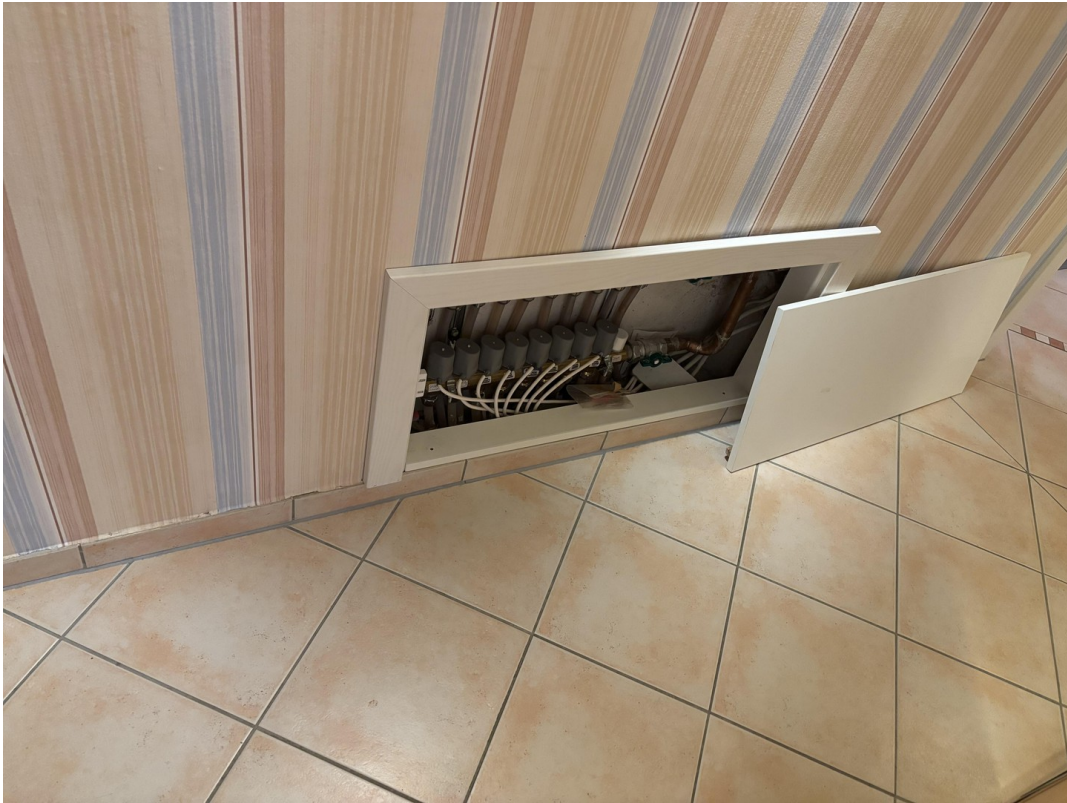
Fußbodenheizung
