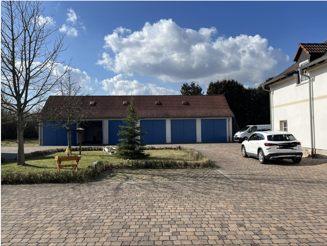
Innenhof Blick auf Garagen
