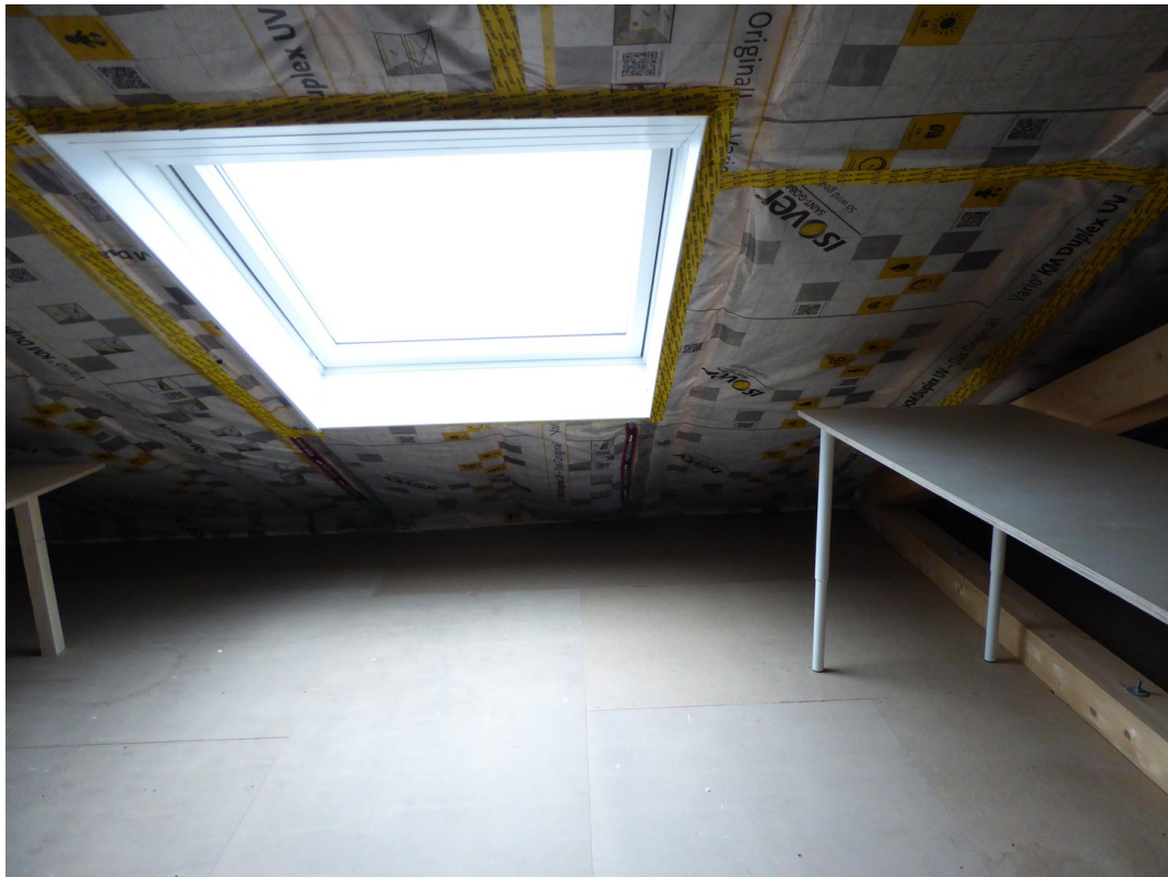
Dachboden el. Fenster
