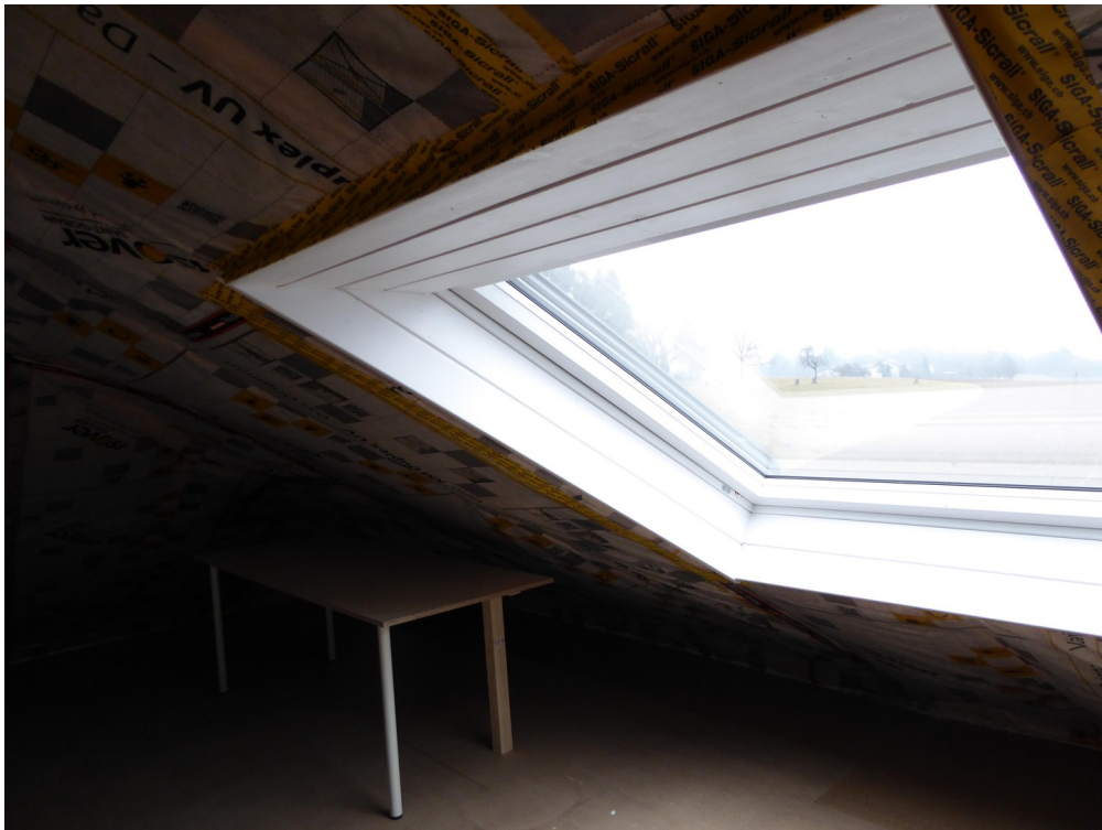
Dachboden nicht bei WF
