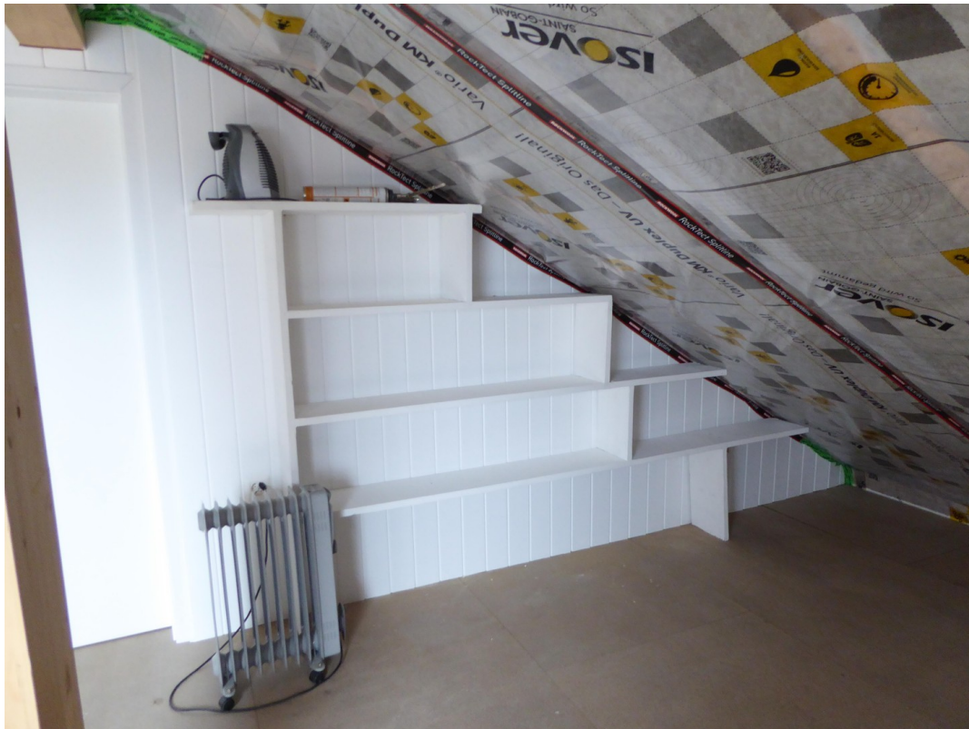
Gestell bleibt auf Dachboden
