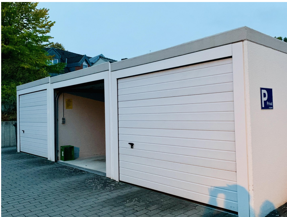
Garage vorne rechts
