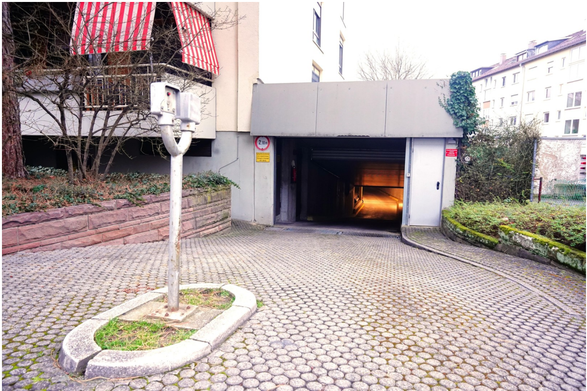
Tiefgarage von Straßenseite
