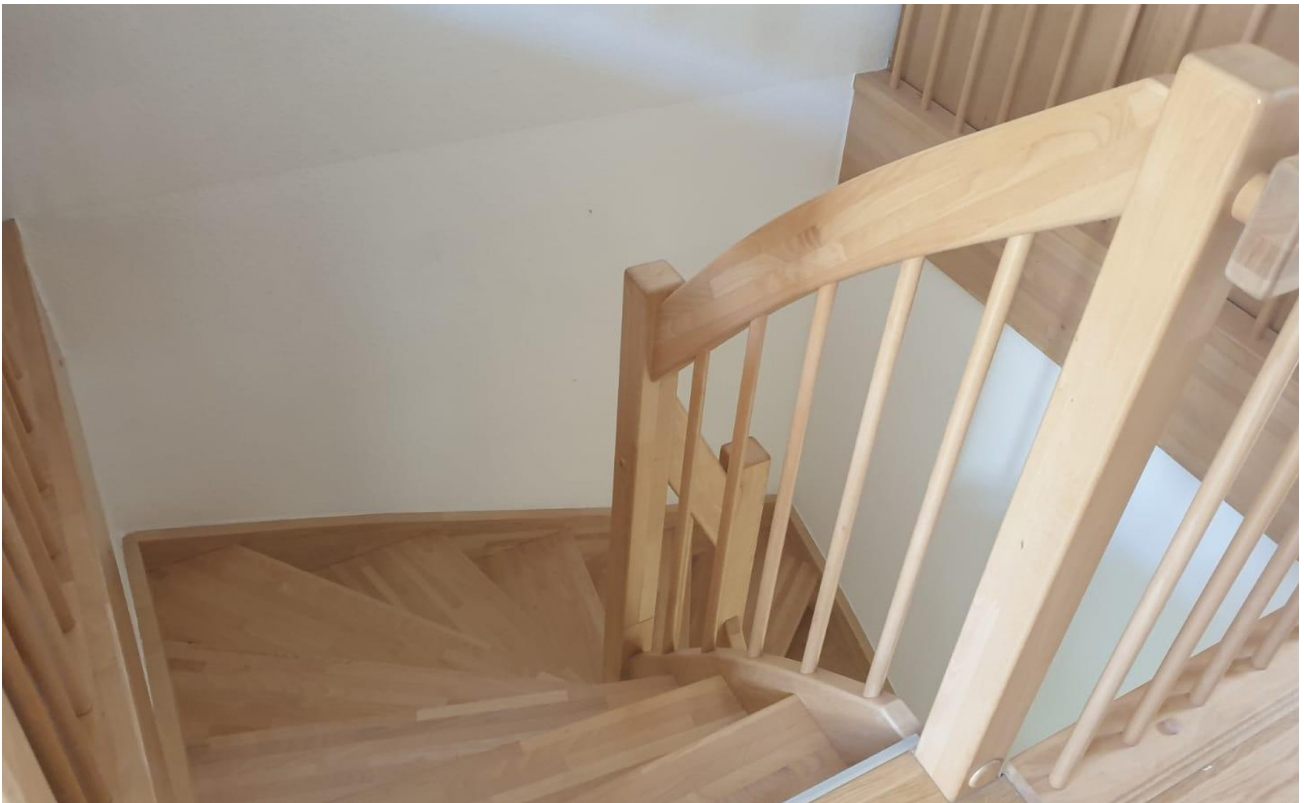
Echtholztreppe zum OG und DG
