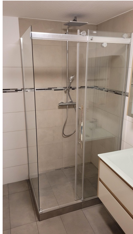
Bad mit Dusche (2023) im OG
