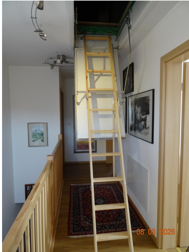
Aufgang zur Abstellfläche Dach
