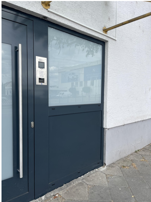
Hauseingangstür / Entrance Dr.
