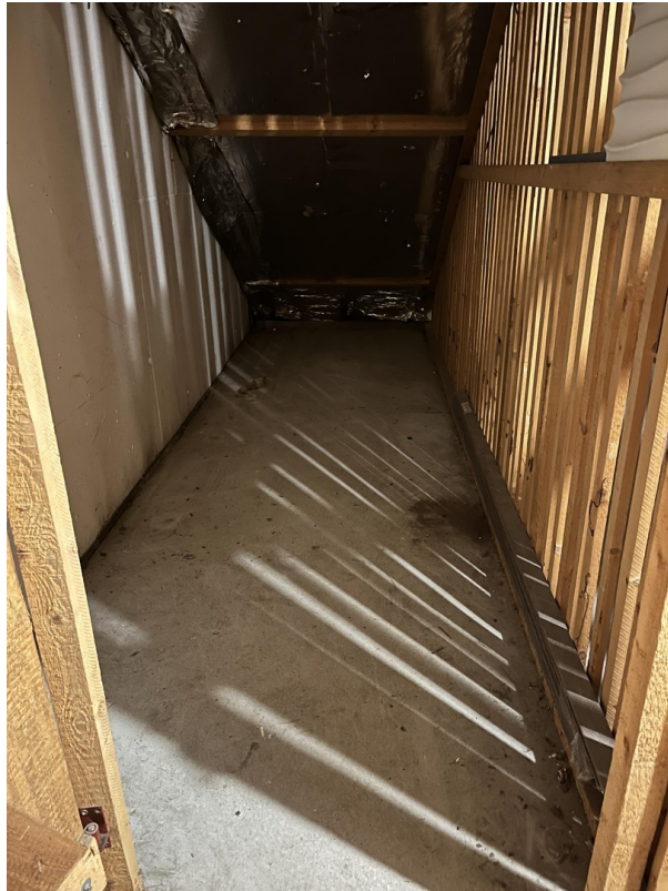
Dachboden Abteil / Attic Comp.
