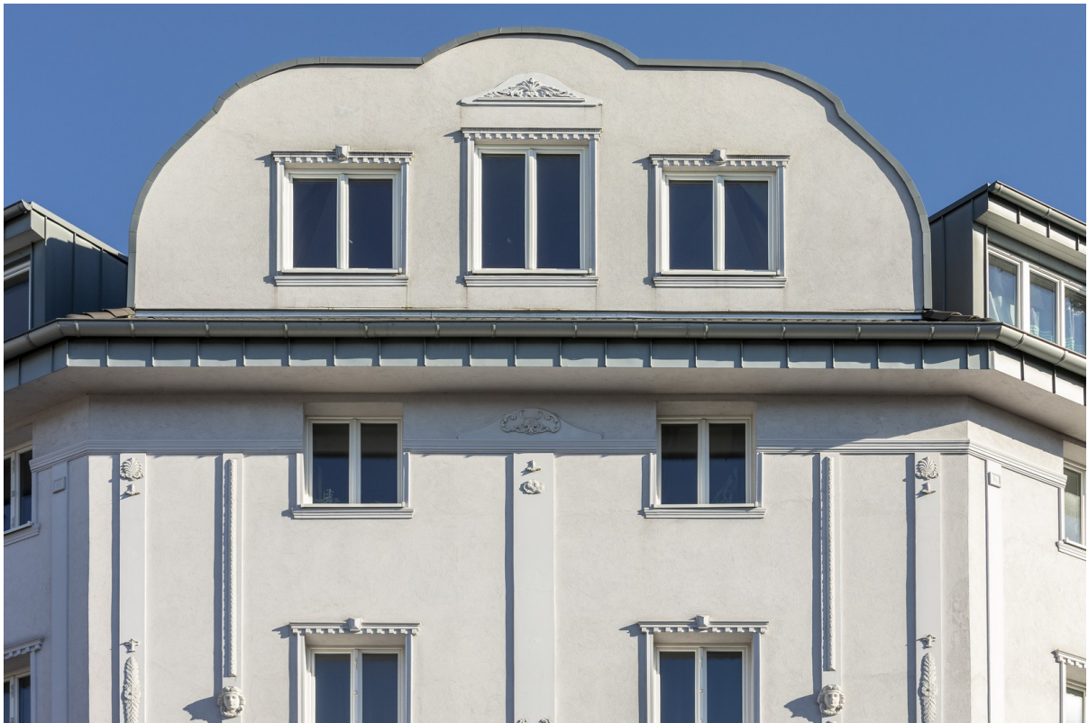
Wärmedämm-Fassade mit Stucco
