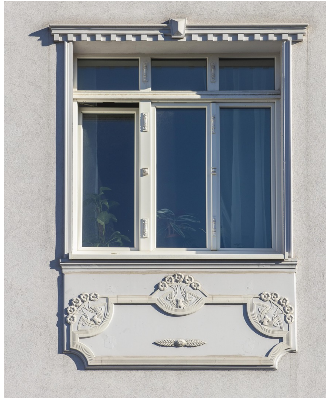
Wärmedämm-Fassade mit Stucco
