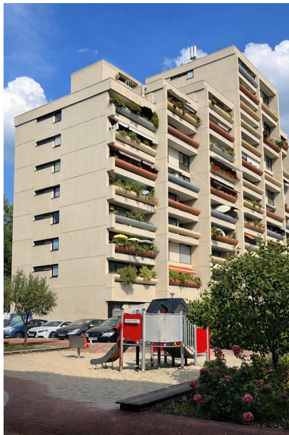
Seitenansicht des Gebäudes
