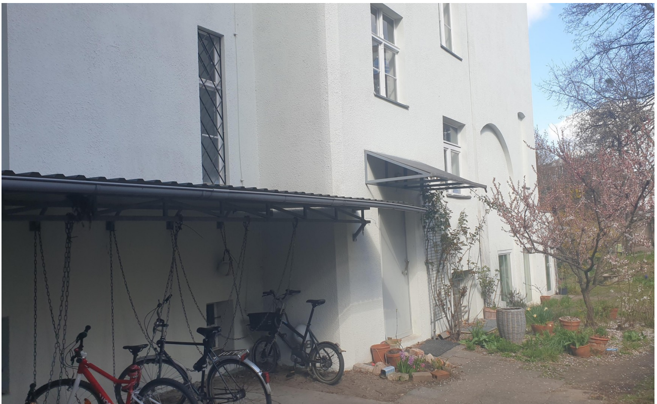
Eingang zum Seitentreppenhaus
