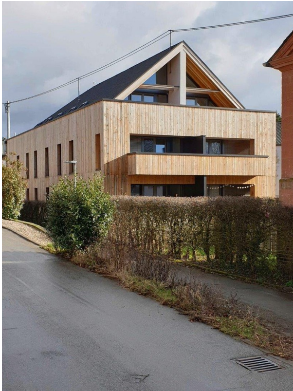
Blick von Südwesten-Ziegelstr.
