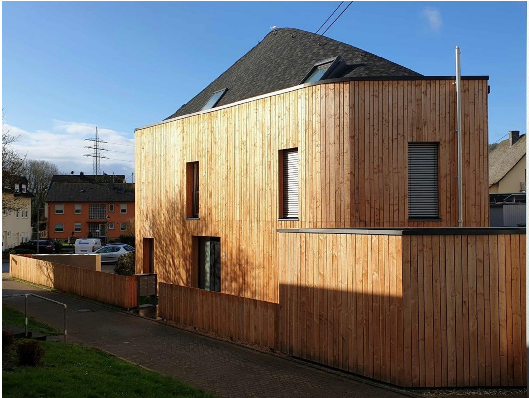
Blick von Nordosten
