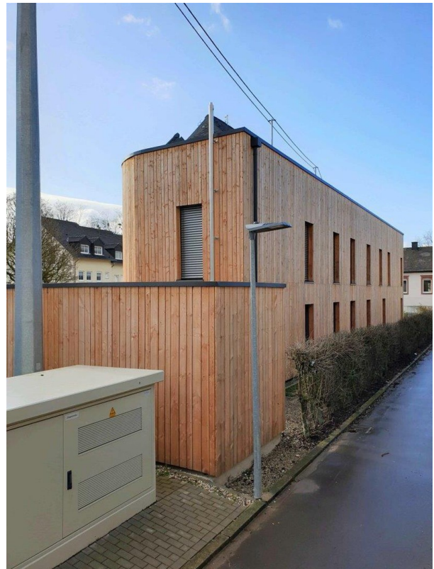
Blick von Norden
