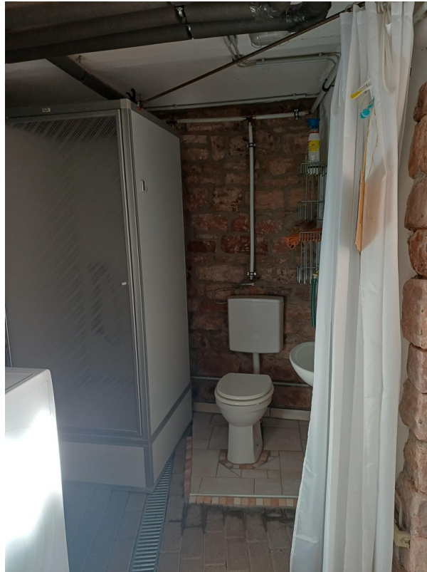
Keller/Duschbad in Waschküche
