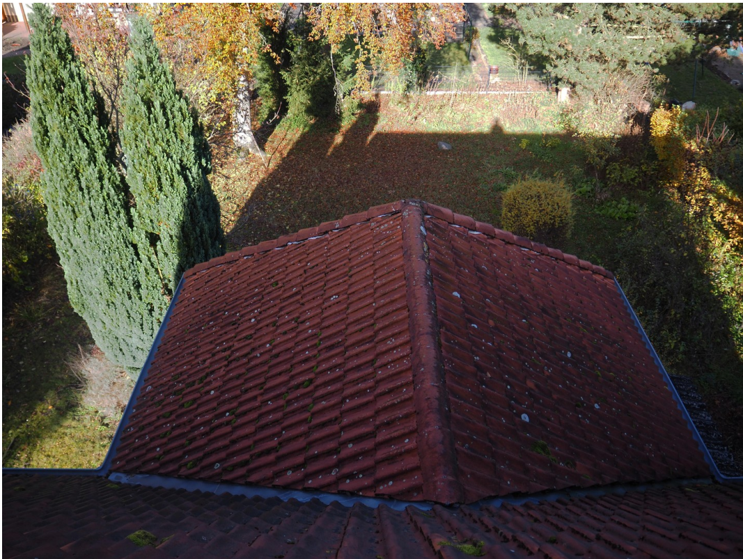
Blick auf Dach Anbau
