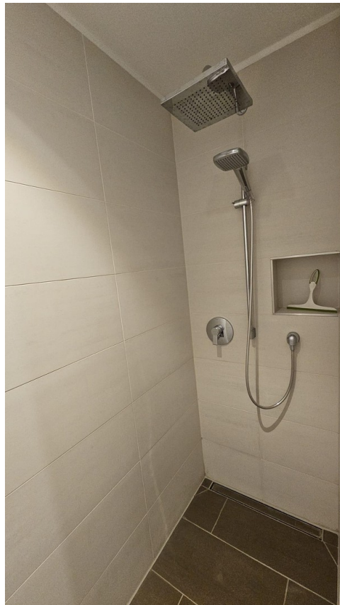
Dusche im 1. OG
