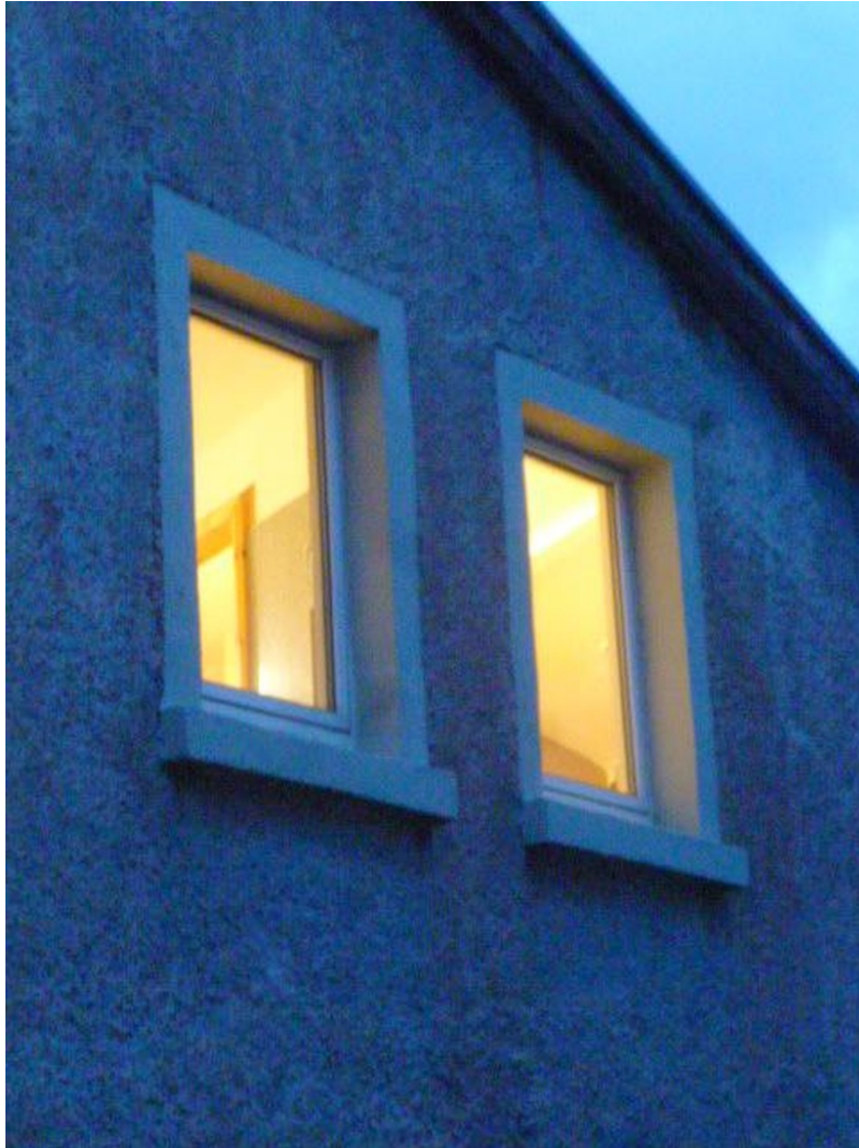
Außenansicht Küche und Flur
