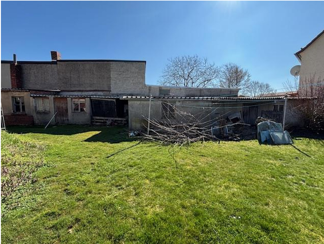
Gartenansicht auf Nebengebäude
