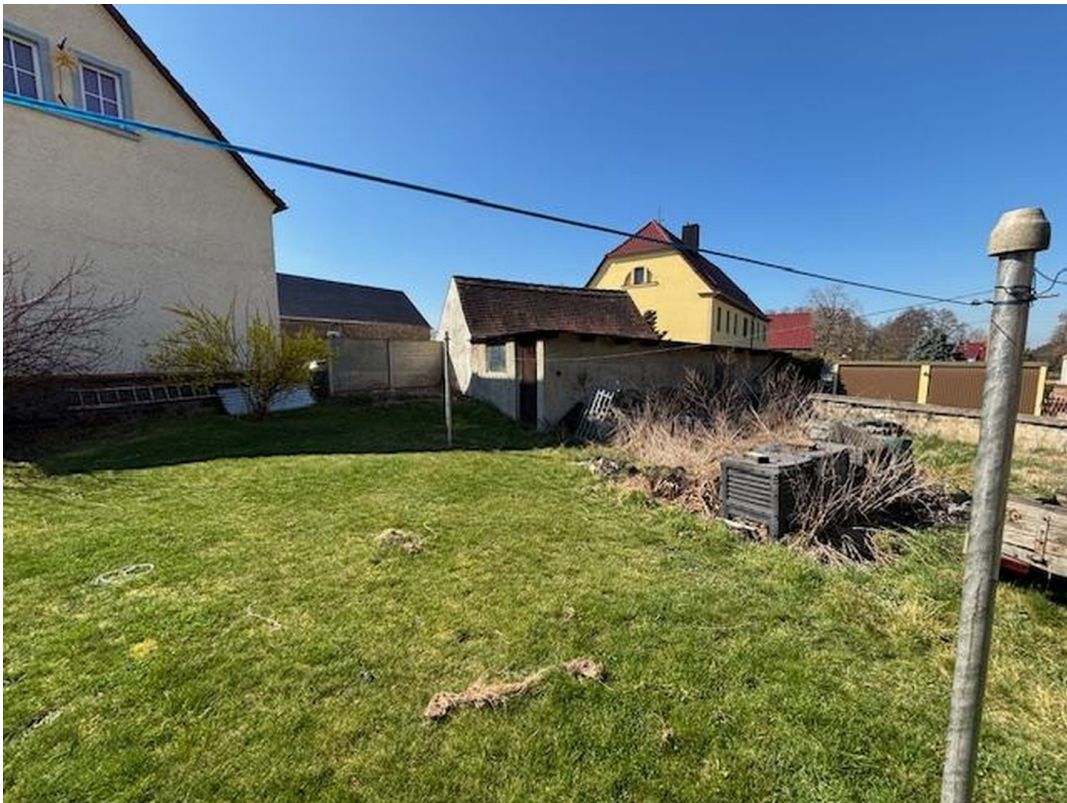
Gartenansicht auf Garage
