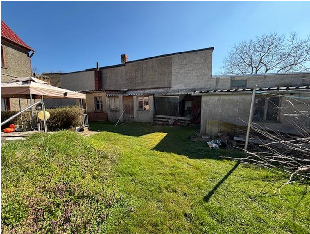
Gartenansicht auf Nebengebäude
