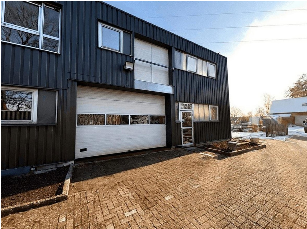
Außenansicht Rolltor / Tor
