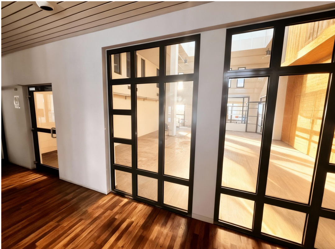
Ansicht zum Atrium EG
