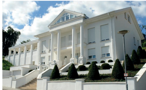
Einfamilienhaus in Goldbach
