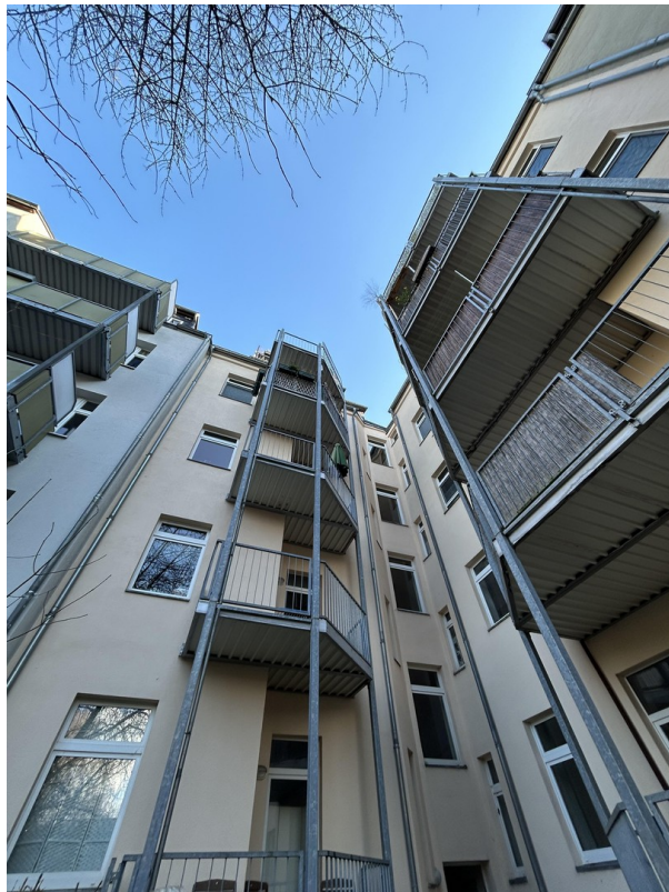
Blick auf die Rückseite außen
