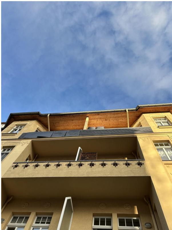
Dach von unten
