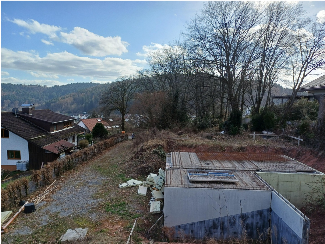
Baustelle nach Süd-Westen
