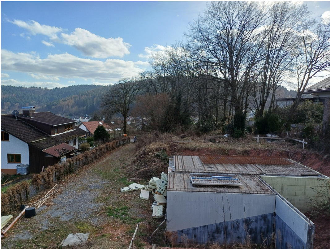
Baustelle nach Süd-Westen
