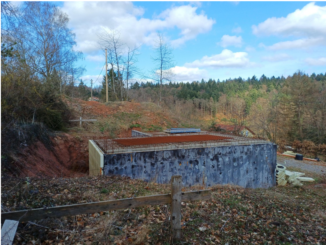
Baustelle nach Osten
