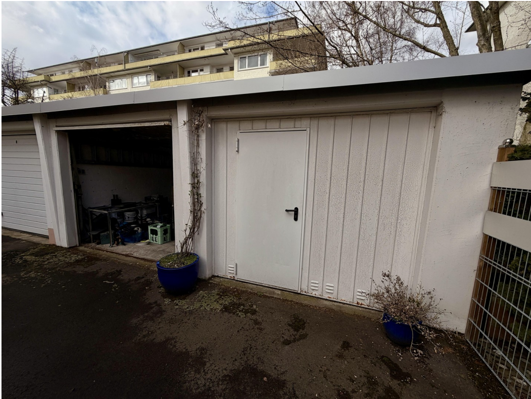
Garage und Garage/Hobbyraum
