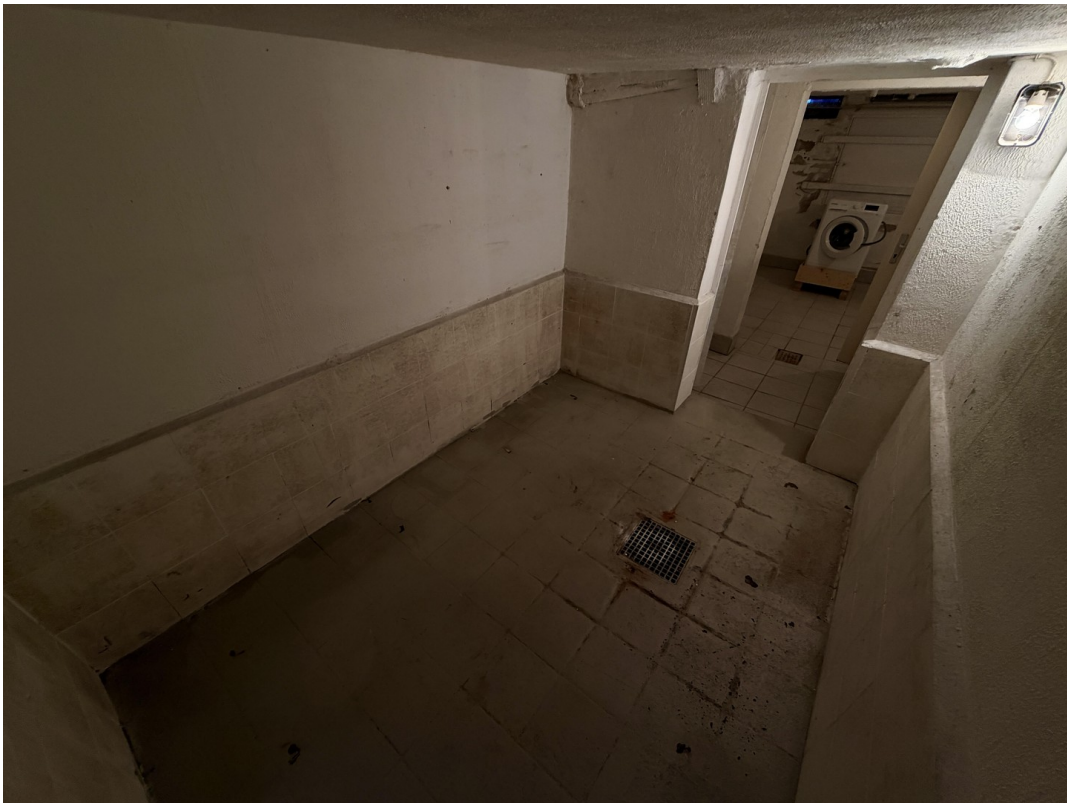
Kellerraum (ehemals Kühlraum)
