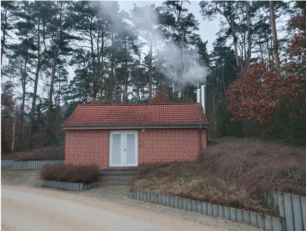
Heizwerk im Hafendorf
