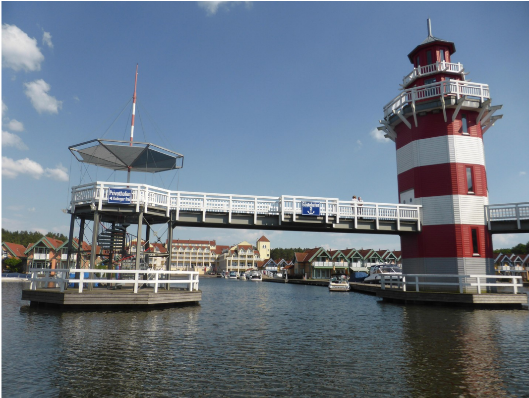
Brücke am Leuchtturm
