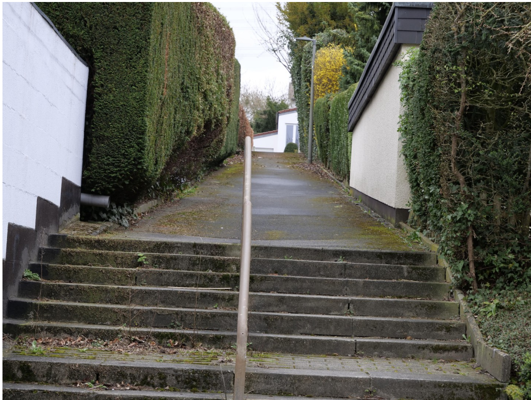
Weg zur Garage
