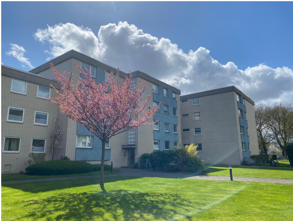
Blick auf Wohnanlage
