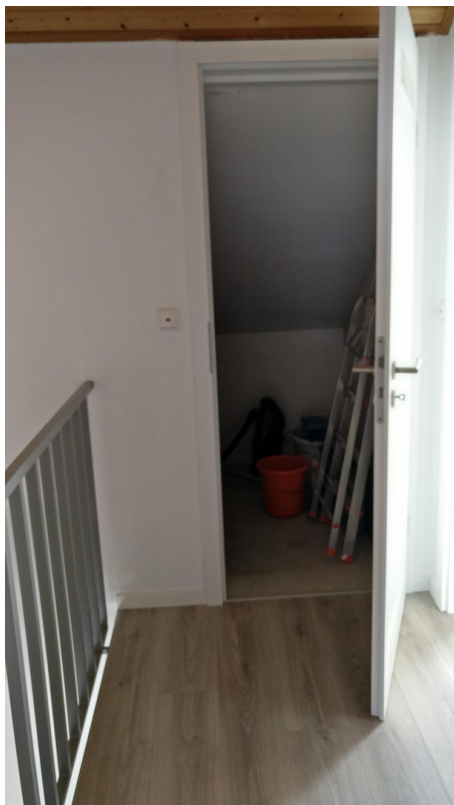
Abstellraum mit Gas-Therme
