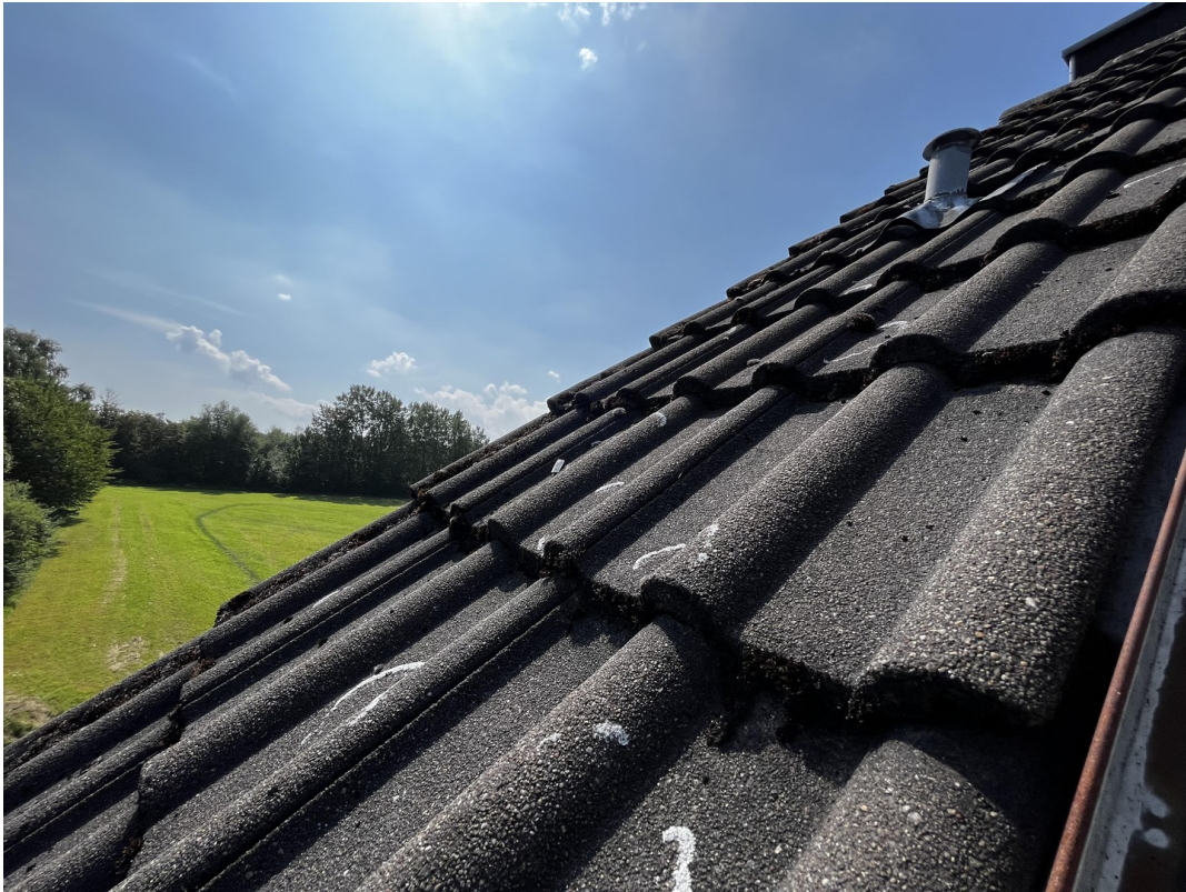
Blick auf die Dachfläche
