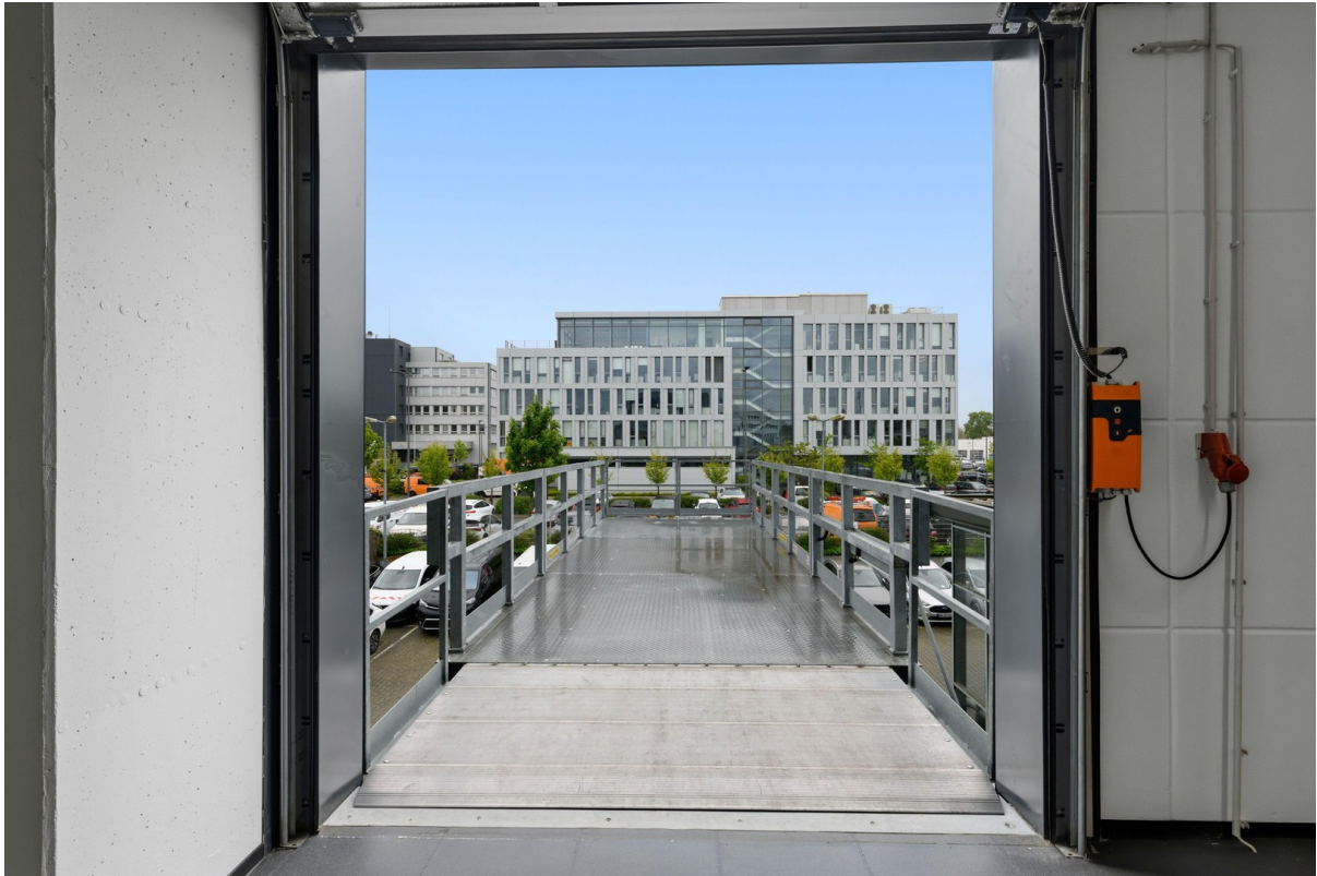
Einfahrt über Hebebühne
