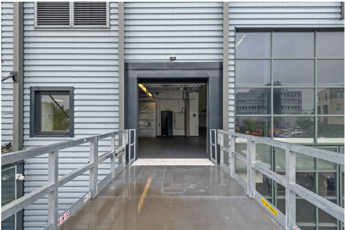
Einfahrt über Hebebühne
