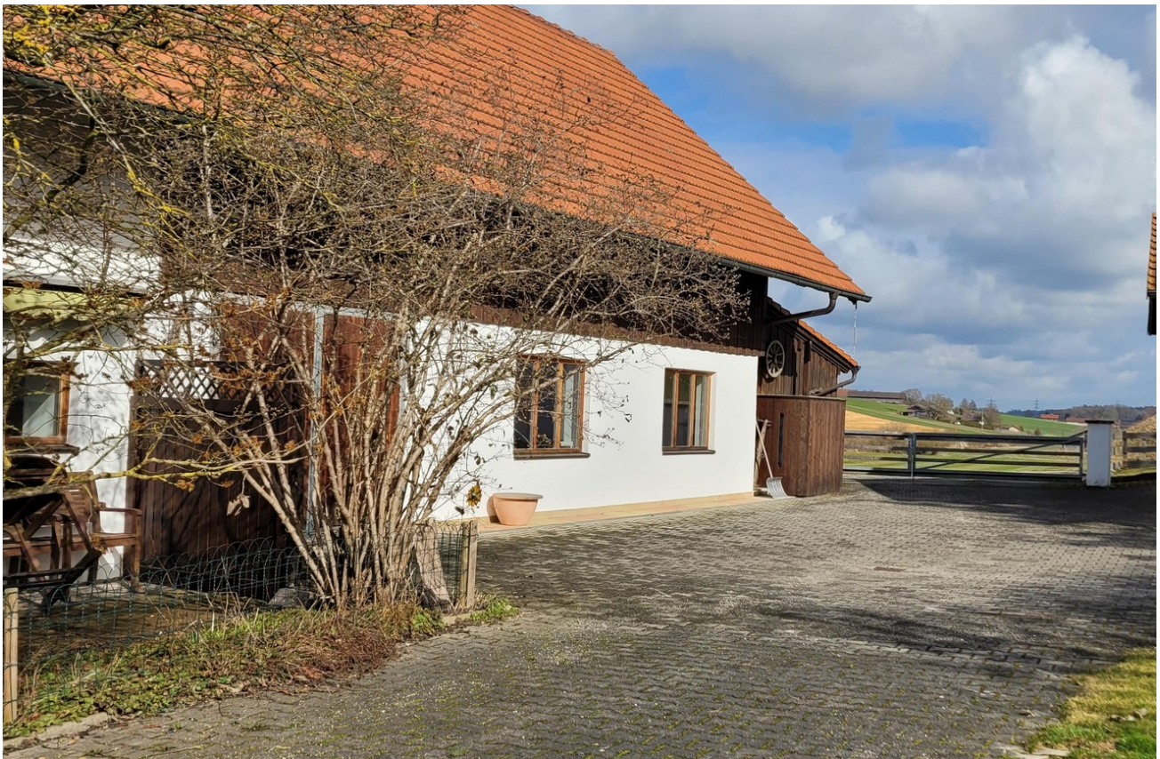
Werkstatt und Nebengebäude
