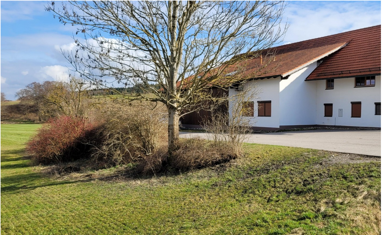
Wohnhaus und Büro
