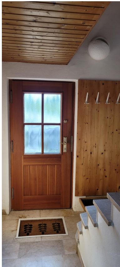
Eingangstür zum Wohnhaus
