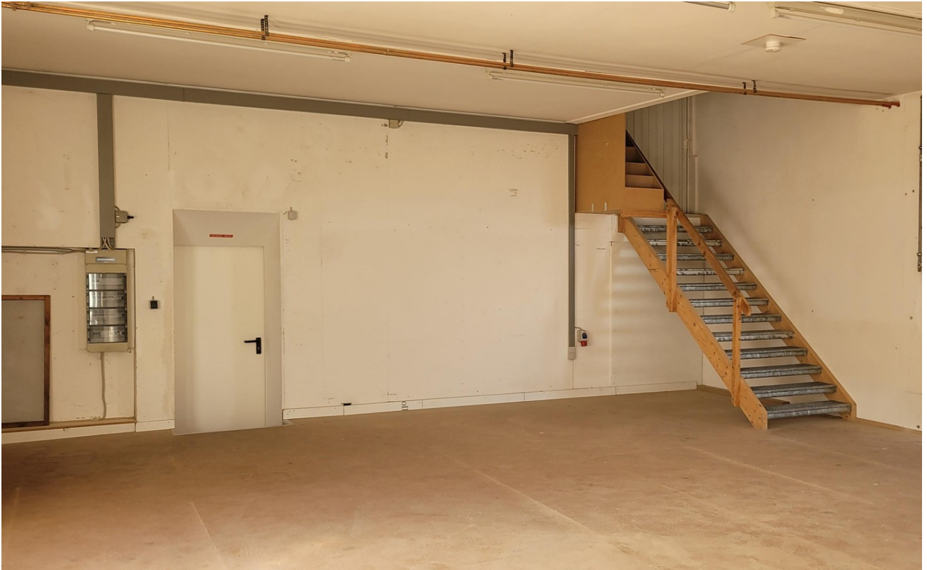
Treppe ins Obergeschoss
