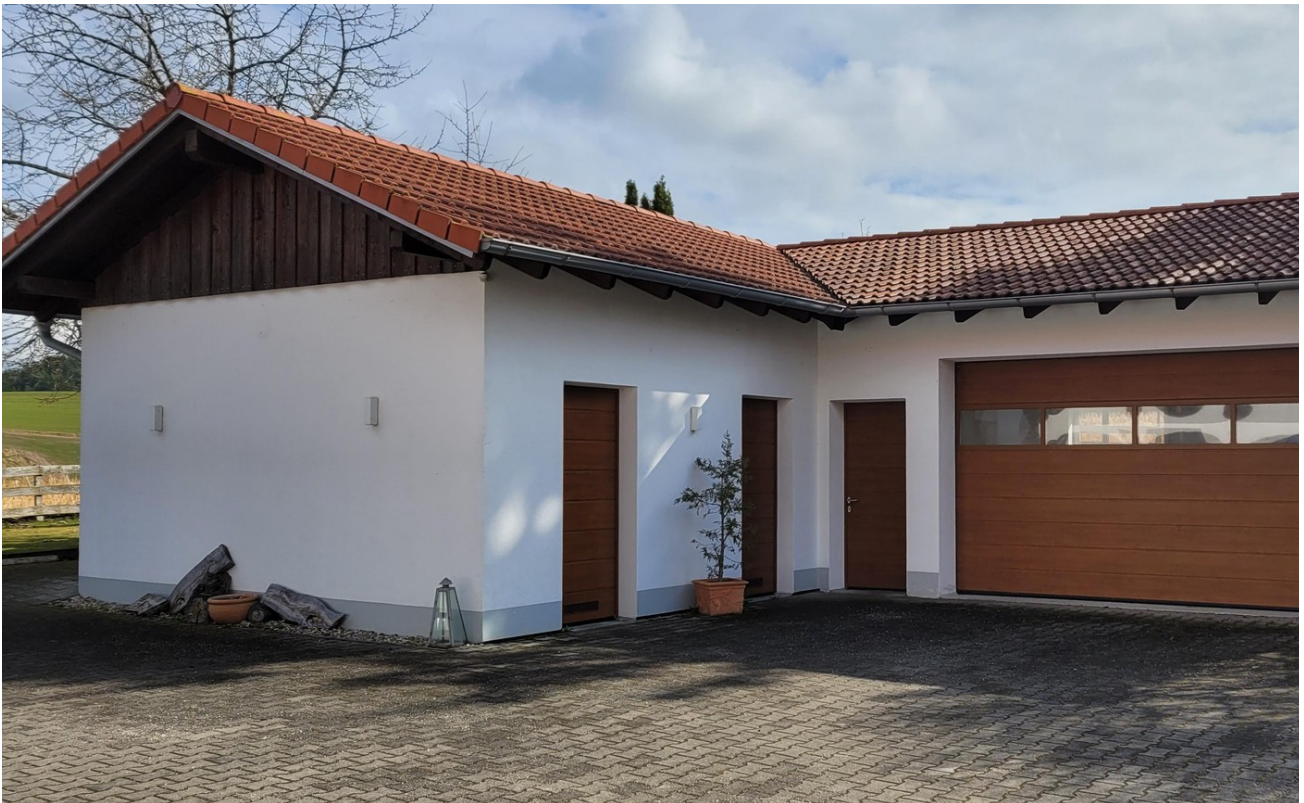
Doppelgarage mit Nebenräumen
