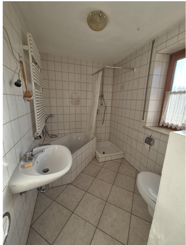
EG Bad aktueller Zustand
