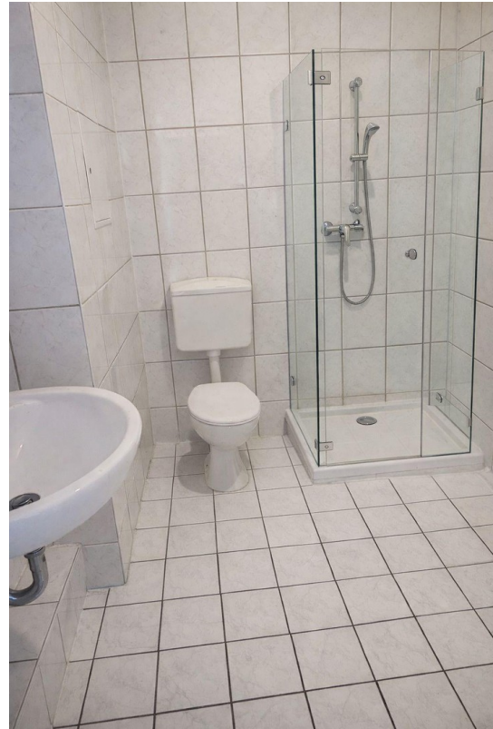
Dusche mit Toilette
