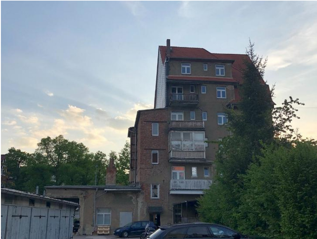
alte Hausansicht hinten
