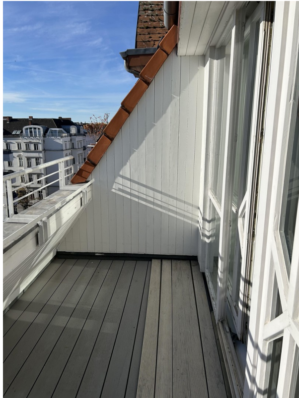
Terrasse zur Straße hin
