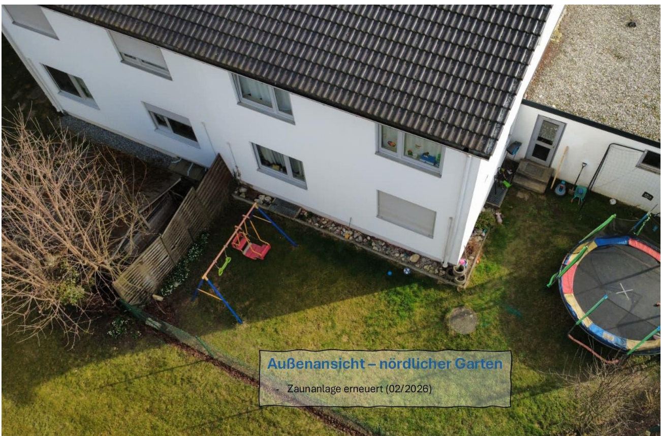
Außenansicht oben nördlich
