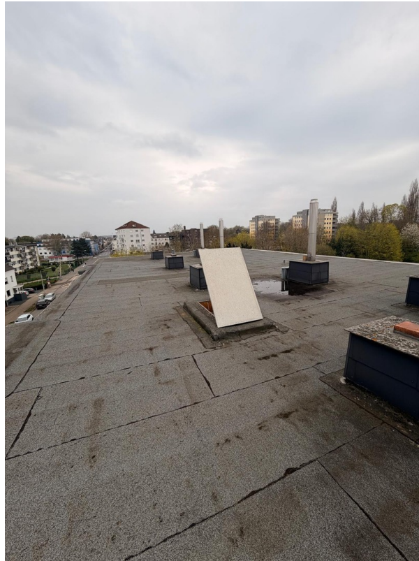
Dach mit zugang
