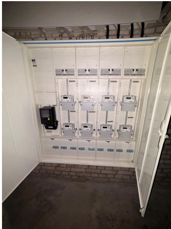
Stromzähleranlage
