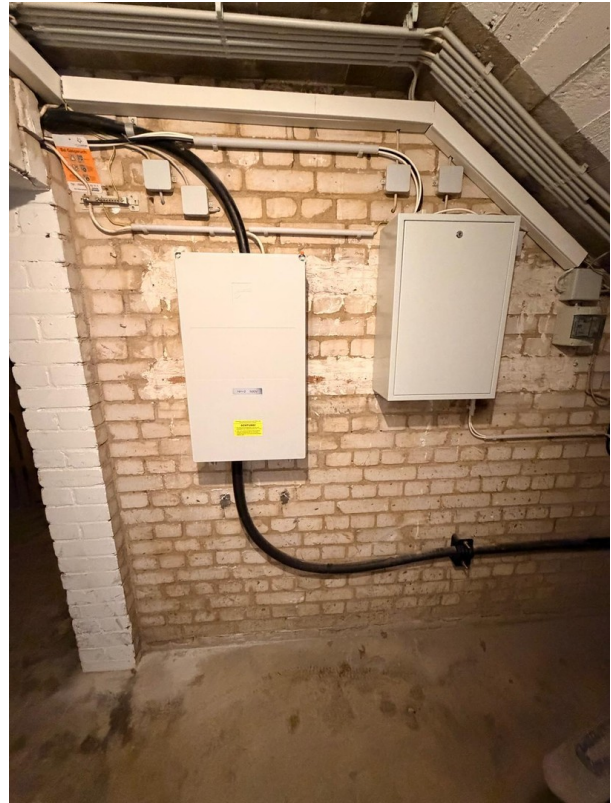
Elektrohausanschluss
