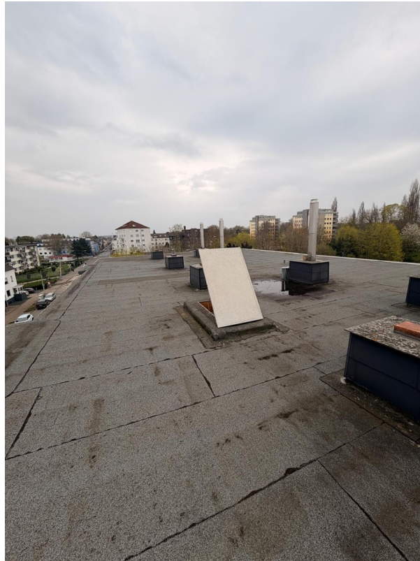
Dach mit zugang
