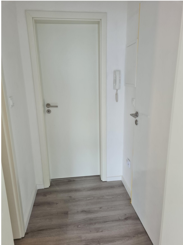
Neue Türen und Zargen
