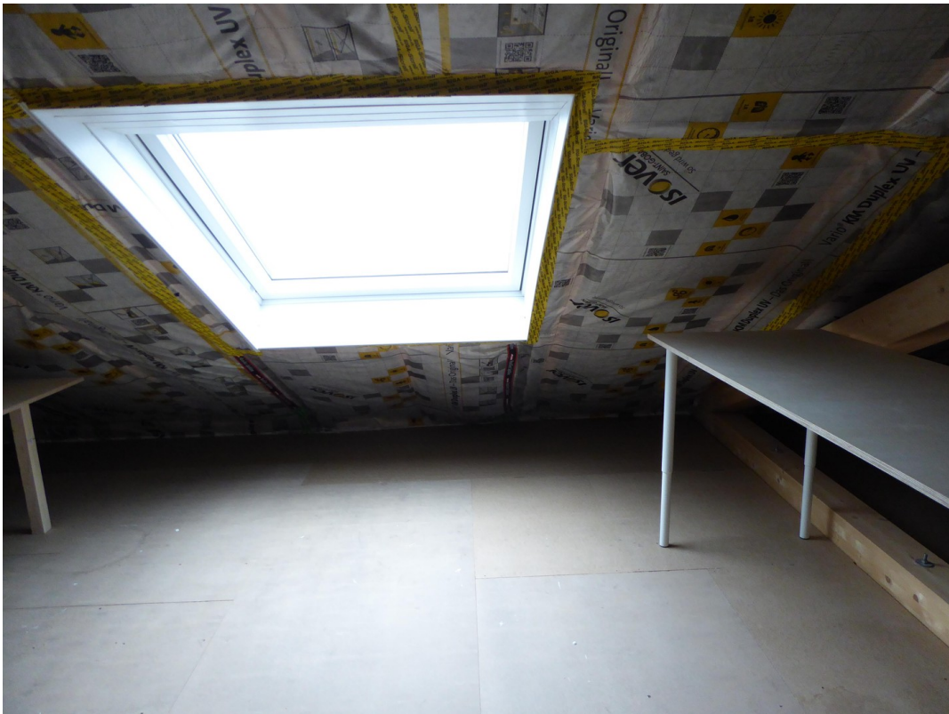
el. Fenster auf Dachboden
