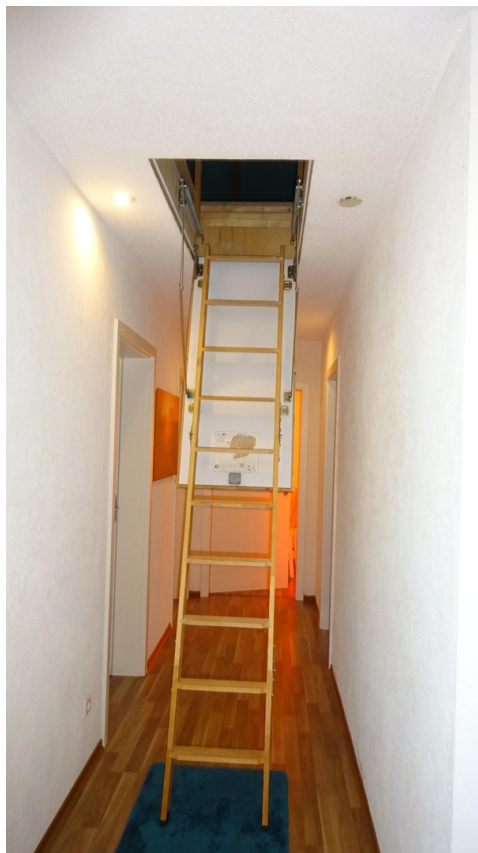
Dachbodenklappe mit Treppe
