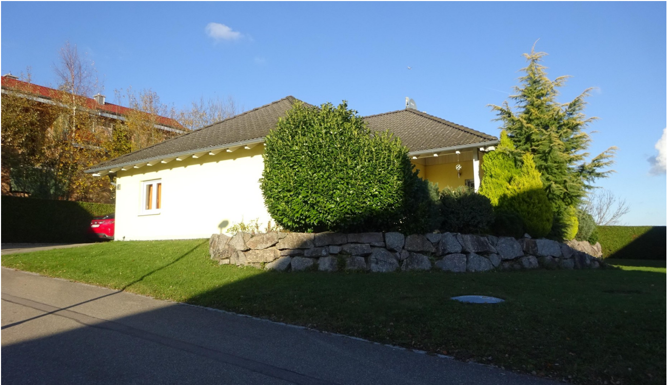
Tankdeckel vom Flüssiggas
