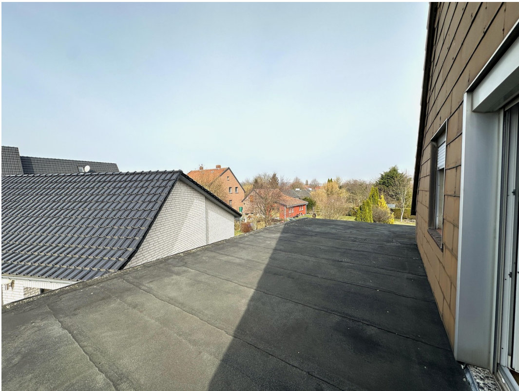
OG Dachterrasse nicht ausgebaut
