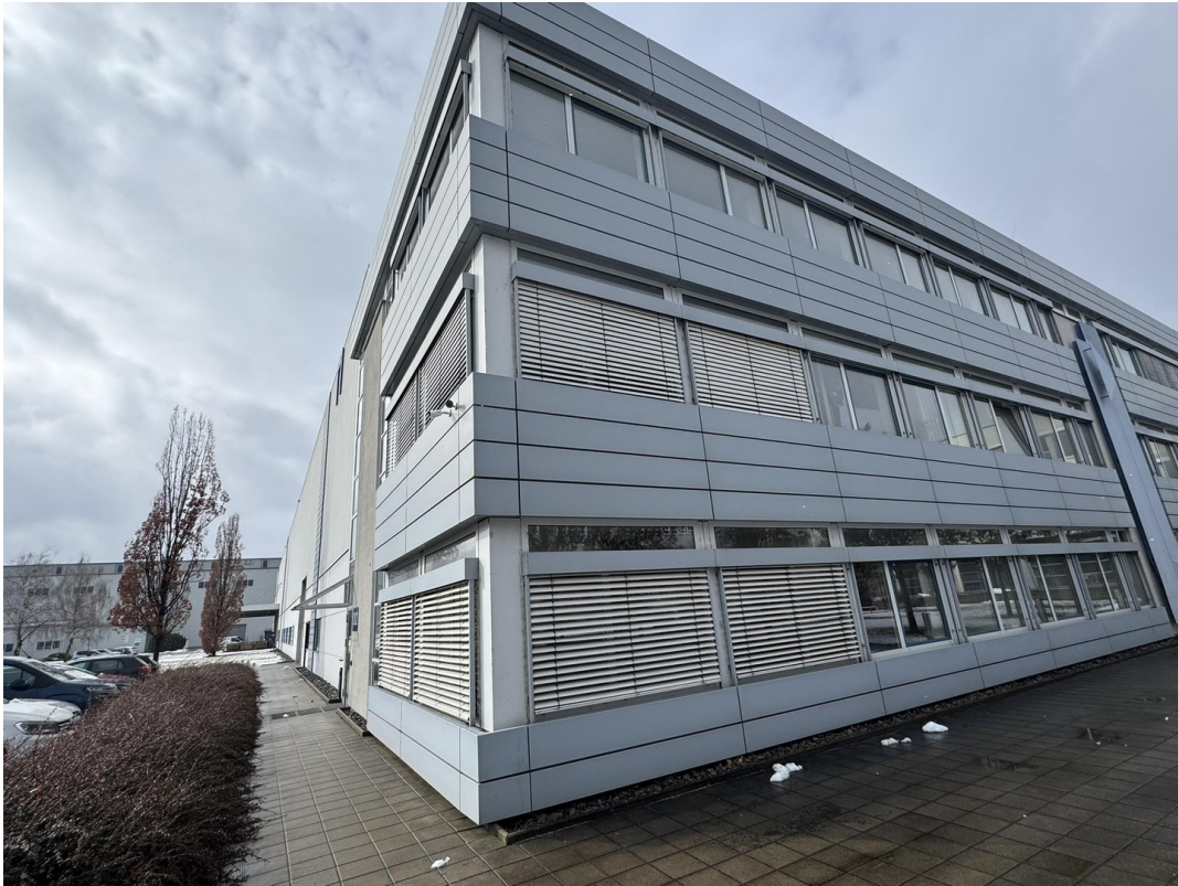
Büroansicht mit Halle
