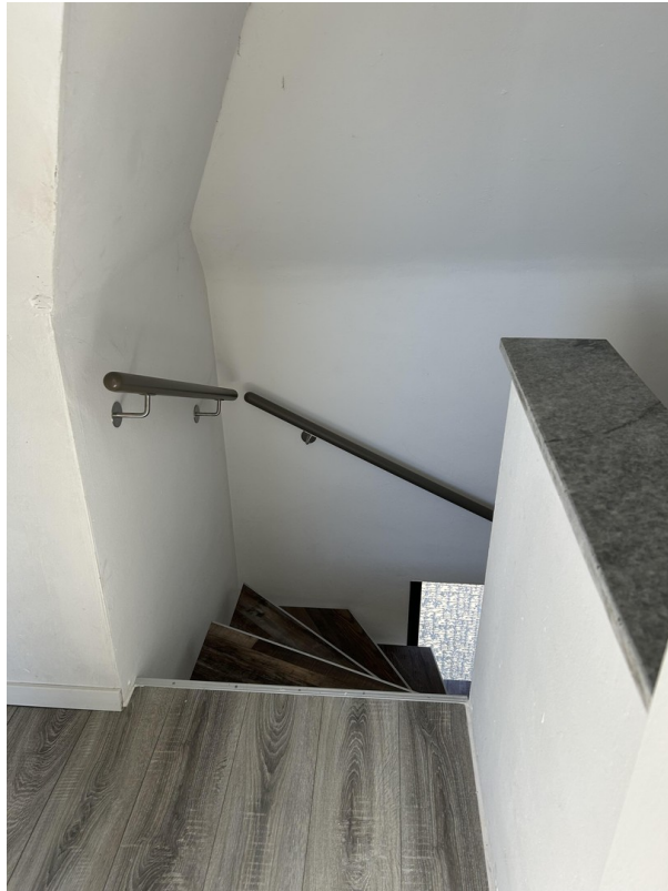
Treppe zum Dachgeschoss
