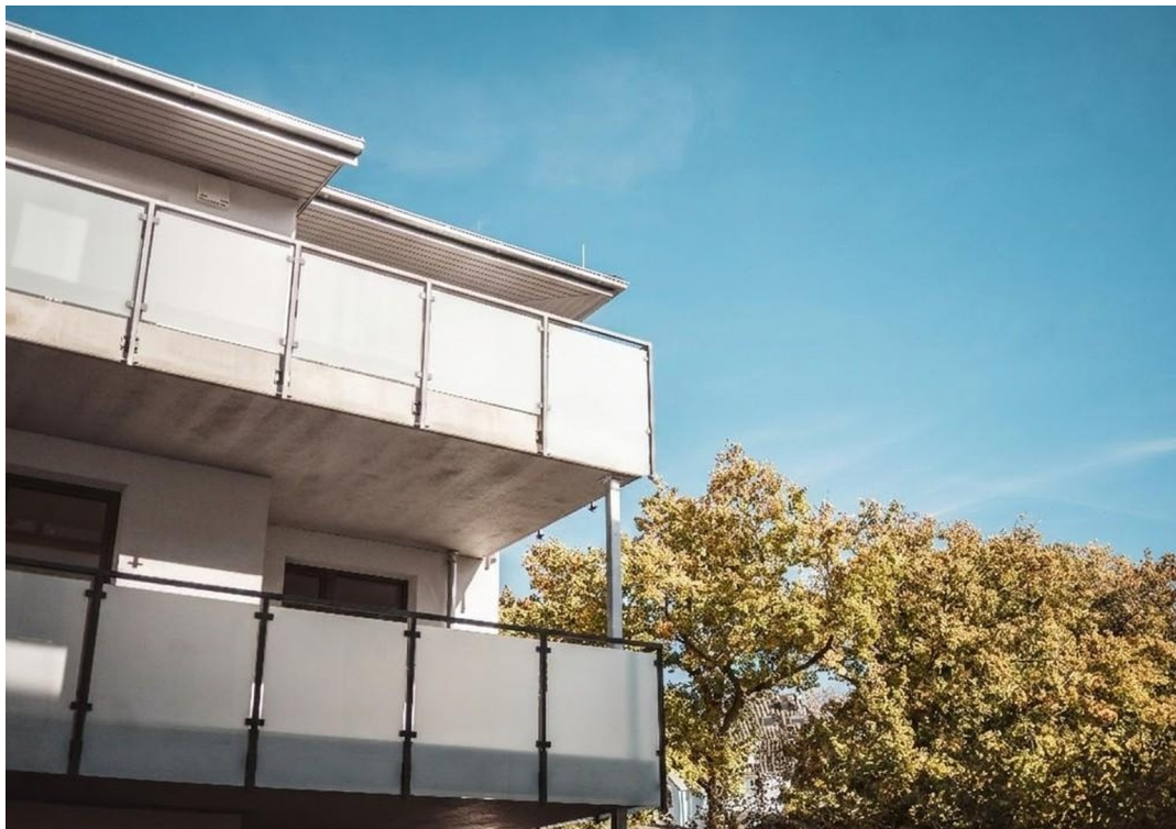
Südbalkon im 1. OG
