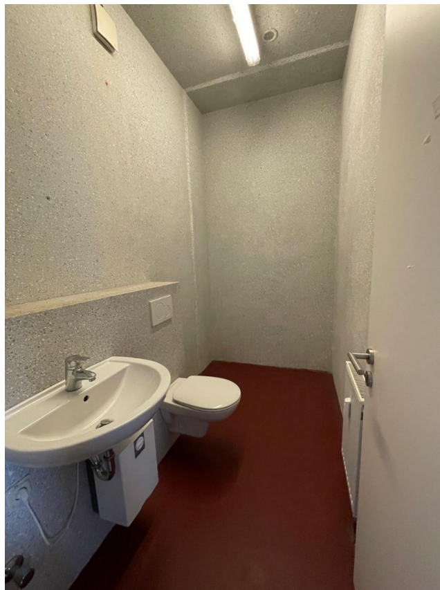
WC und Waschbecken
