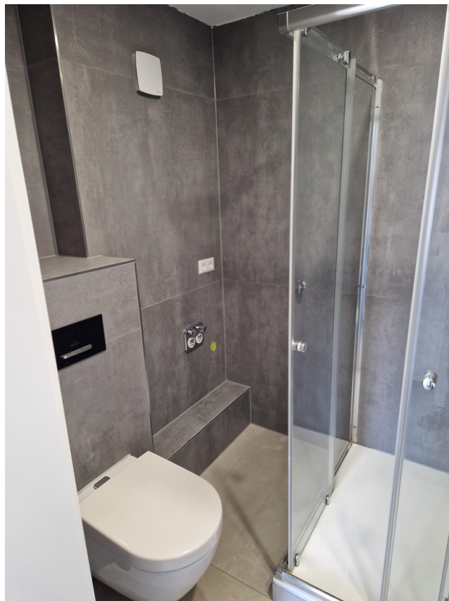
Bad mit Waschmaschinenanschluß
